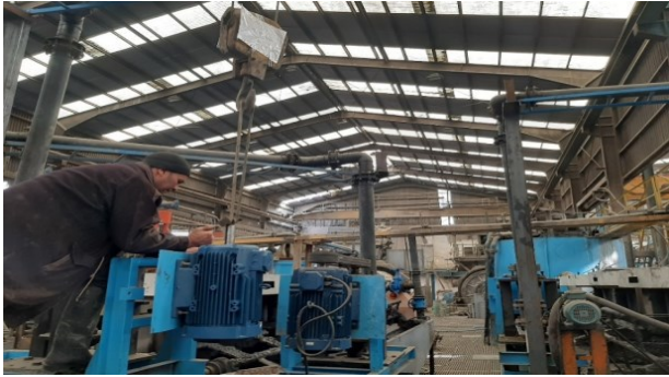
جایگزین نمودن گل کش ۳ اینچی به جای پمپ مخزنی
