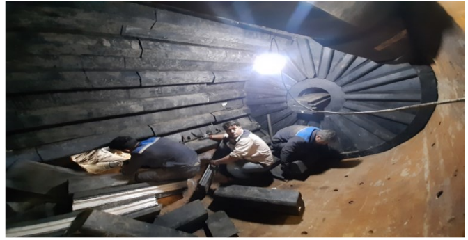
تعویض آسترهای داخلی آسیاهای گلوله ای
